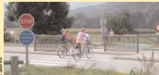
10- Refuge central sur voie large à trafic dense permettant la traversée en deux temps et de manière décalée (cf. cas n° 1)
